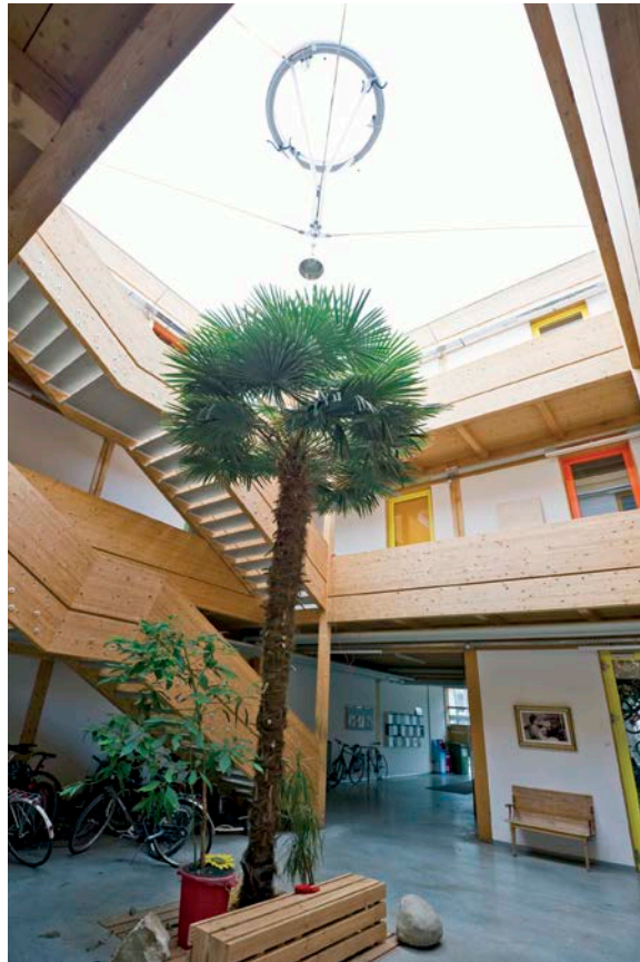
Photo 8.4. Bâtiment tertiaire « Villaban » construit en bois
